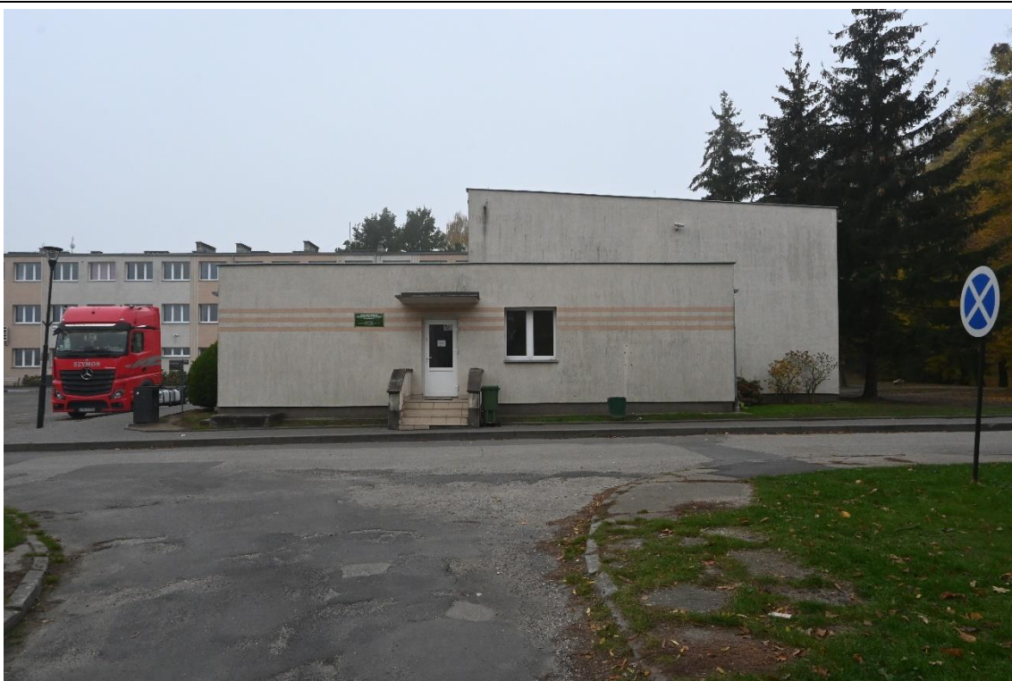
Budynek szkoły w Grubnie – ściana szczytowa części przy sali gimnastycznej
