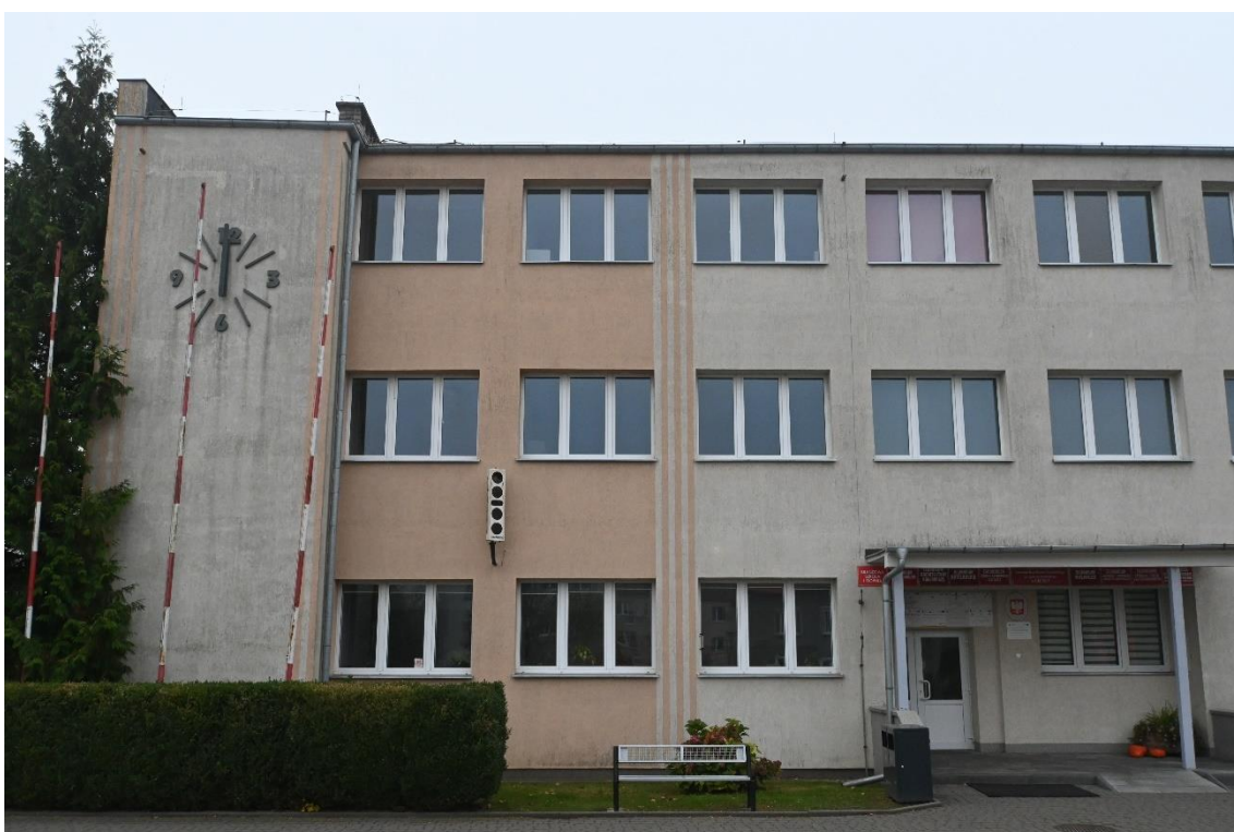
Budynek szkoły w Grubnie – wejście główne do budynku
