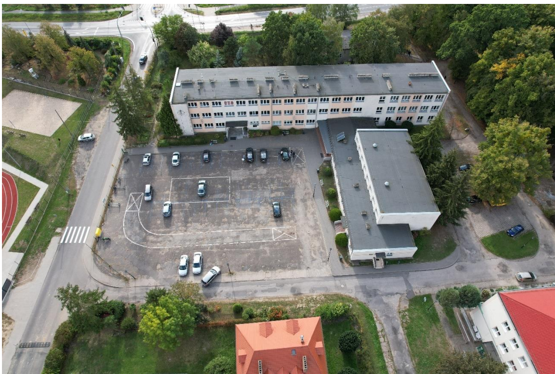
Budynek szkoły w Grubnie
