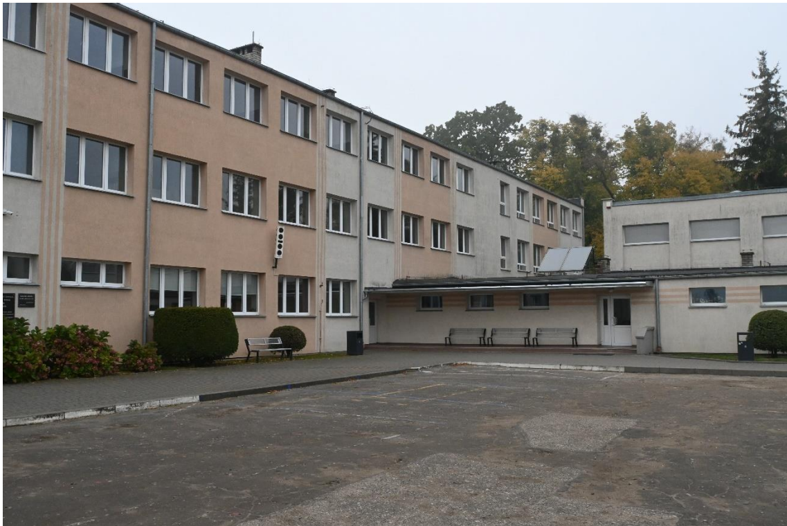
Budynek szkoły w Grubnie – budynek główny z łącznikiem i salą gimnastyczną
