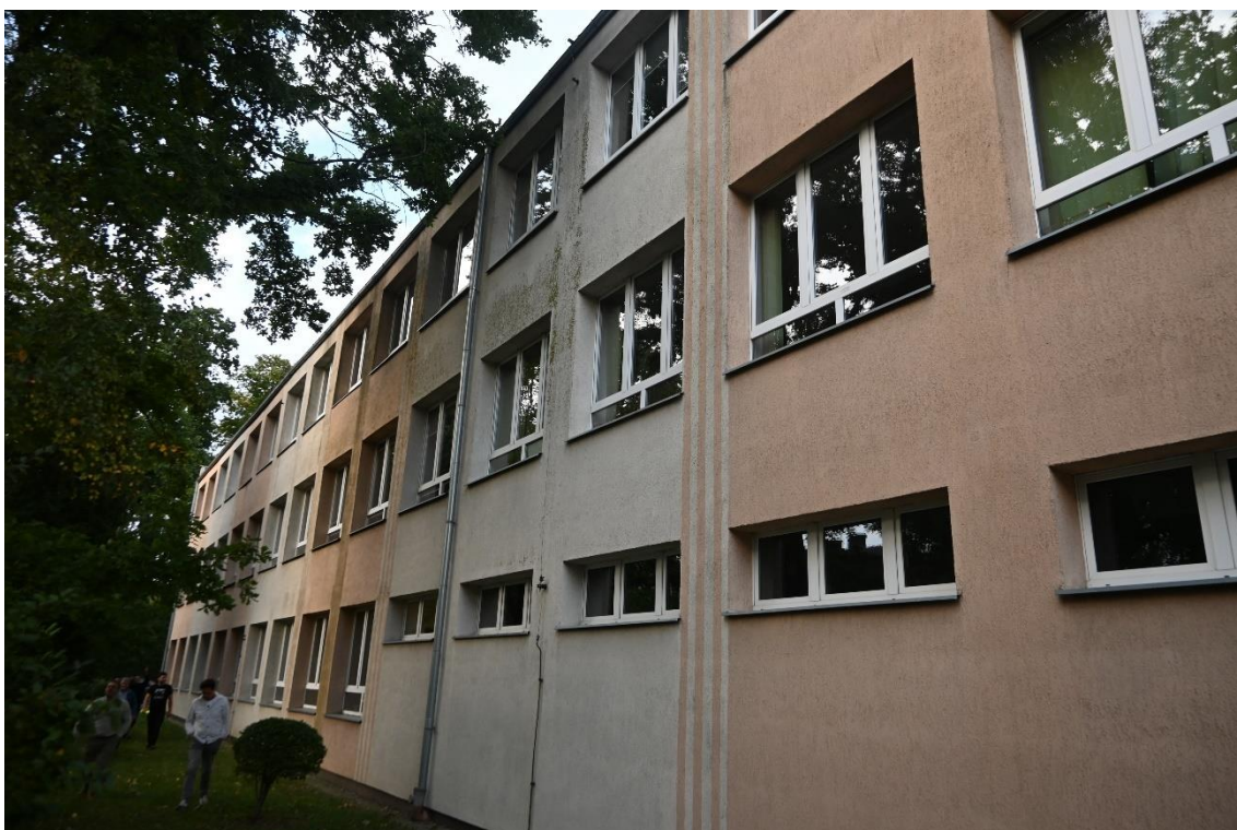
Budynek szkoły w Grubnie – elewacja szkoły od strony zachodniej.
