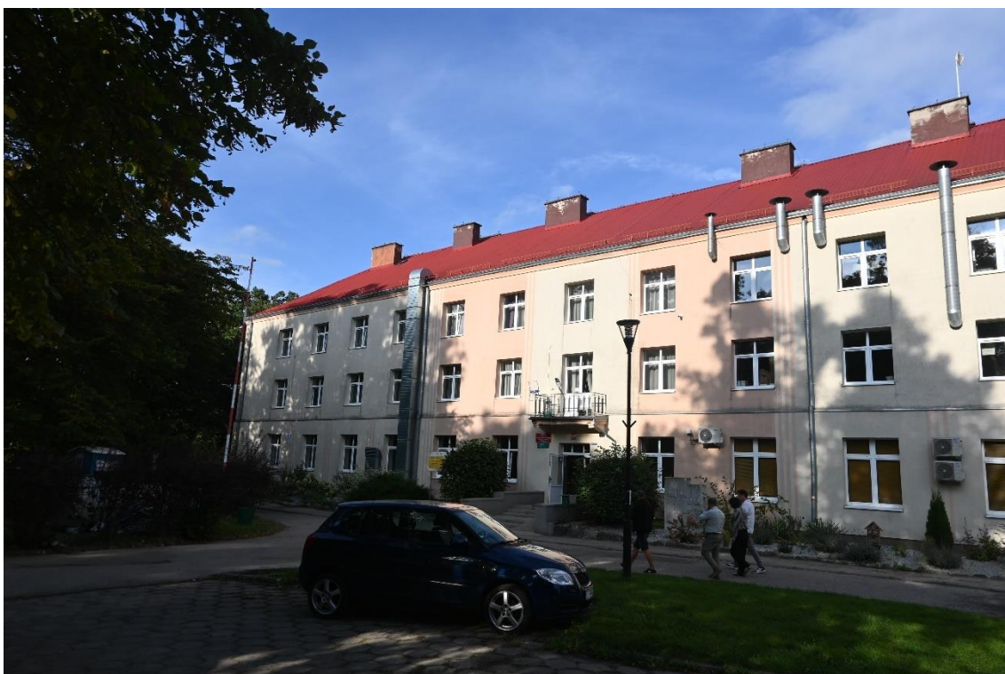
Budynek internatu w Grubnie – elewacja południowo-zachodnia
