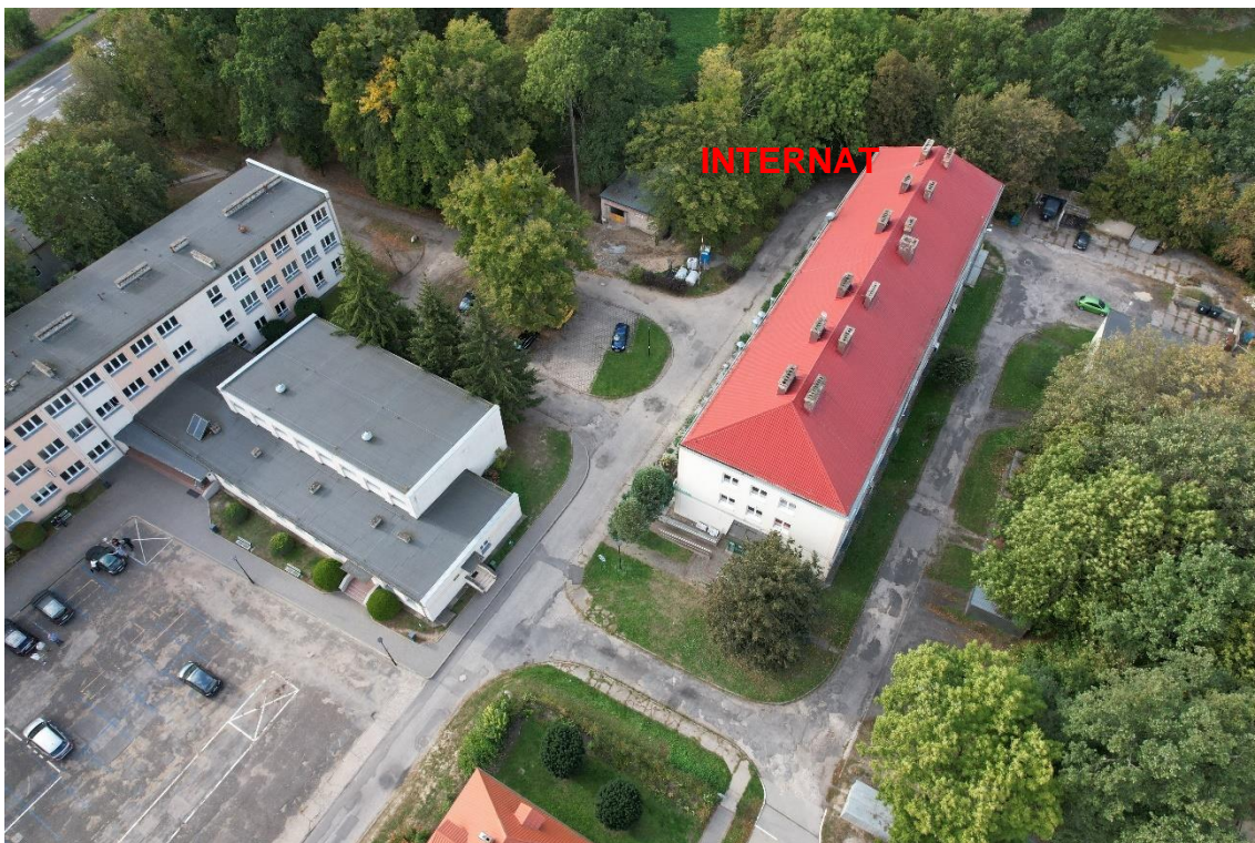
Budynek internatu w Grubnie
