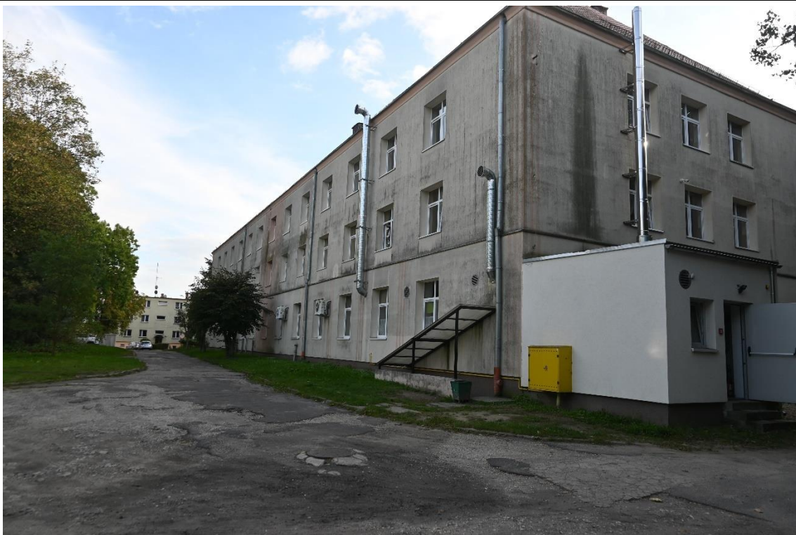
Budynek internatu w Grubnie – widok od strony północnej
