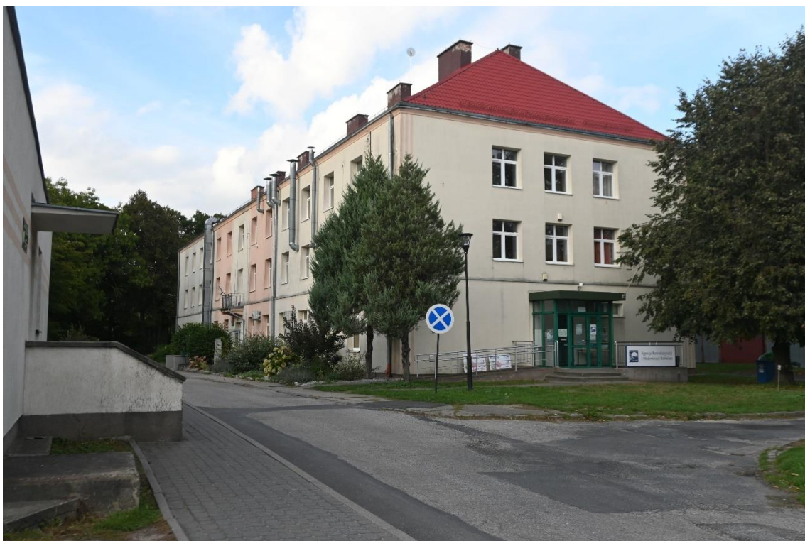
Budynek internatu w Grubnie – widok od strony południowej
