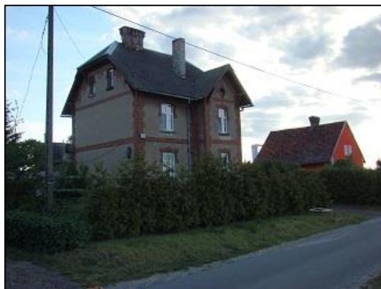
Budynek kolejowy w Firlusie
