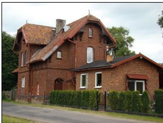
Budynek dawnej stacji kolejowej w Starogrodzie
